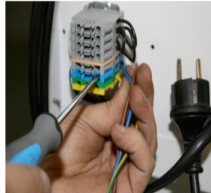
5 Elektrik ve uzak nem ayarlayıcı kablolarını bağlayın.
